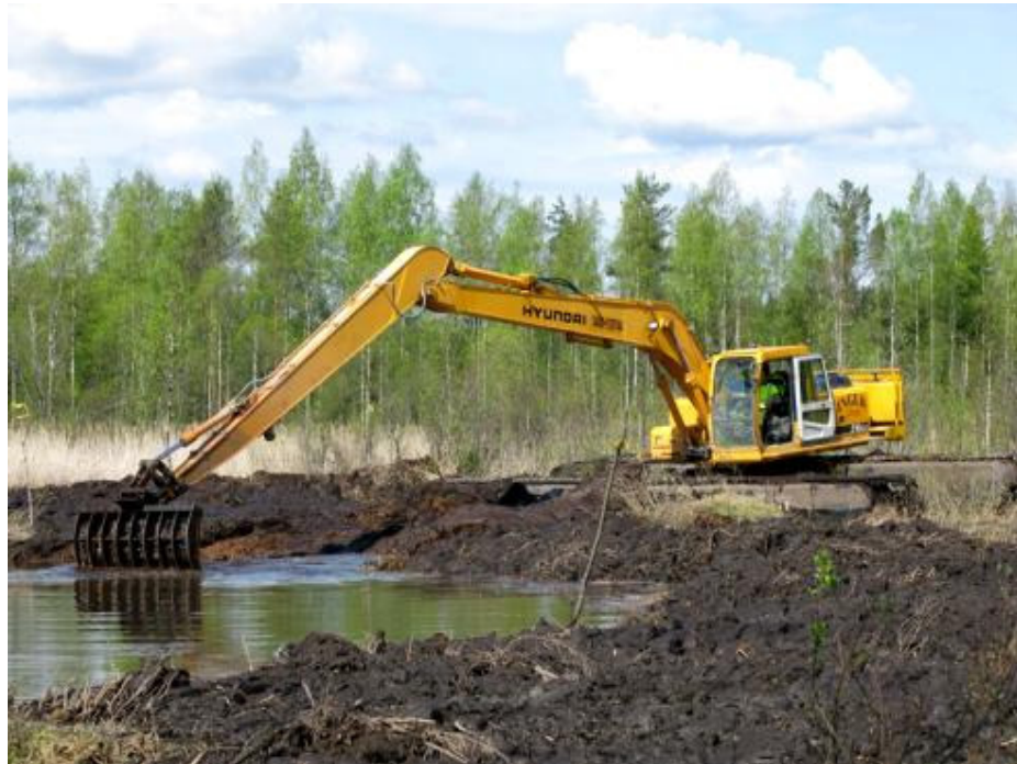
Kuva 7. Ponttoonikaivuri Big Float
